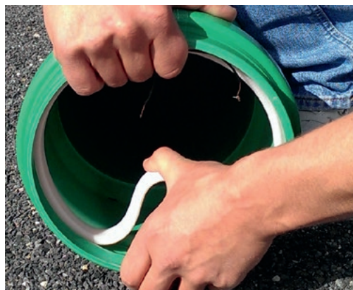
Einlegen des Schweißringes.
