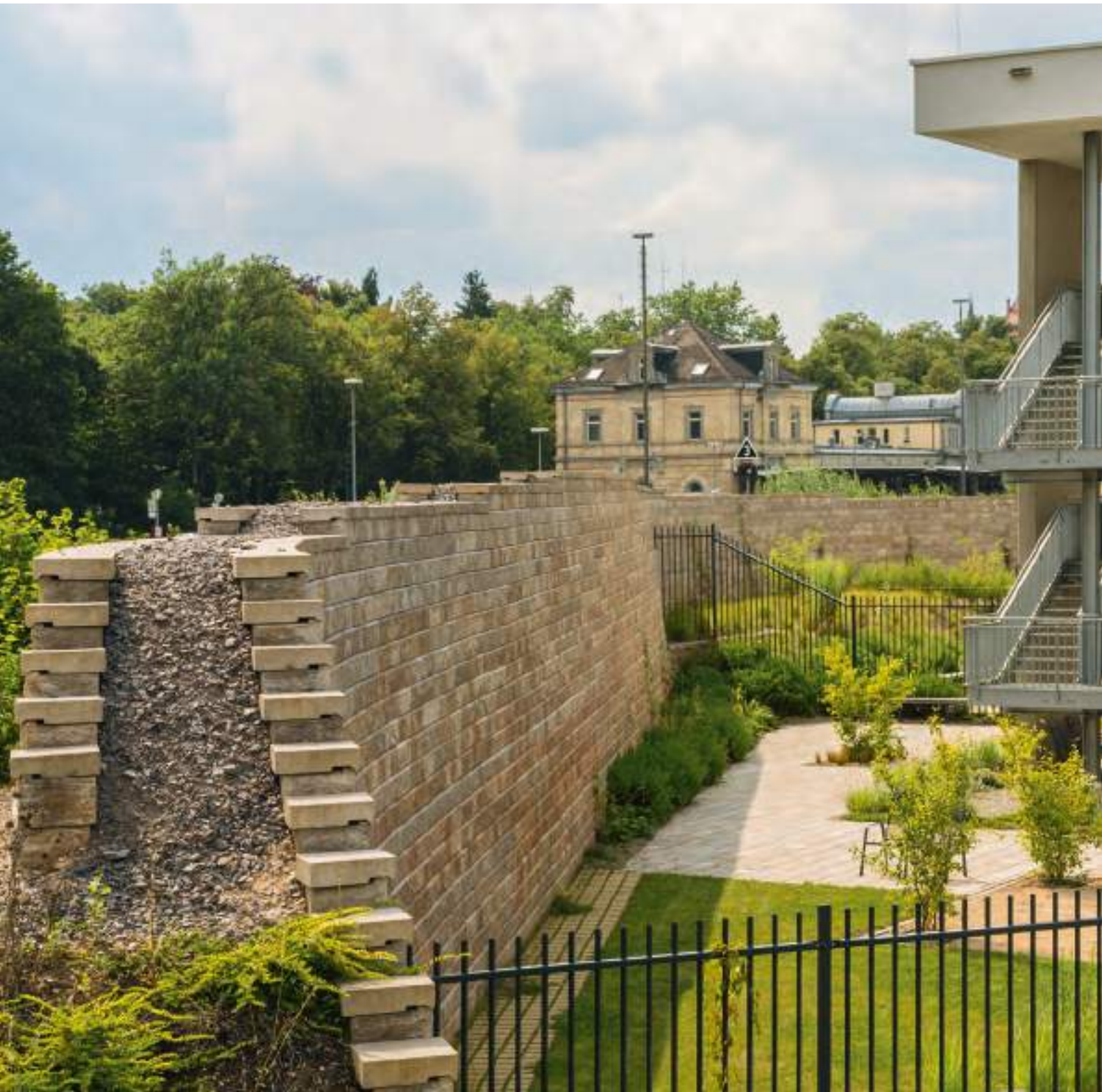
ALLAN BLOCK Muschel-Kalk nuanciert als doppelwandige Mauer mit Schallschutz-Funktion
